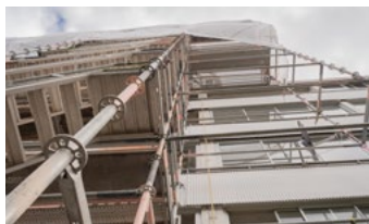
Under hösten gjordes det sista arbetet på Bäckgårdsvägen 38-40.
