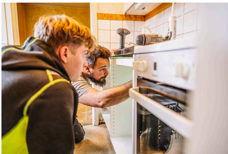
Handledare Christoffer visar Linus hur arbetet med att byta köksskåp går till.
