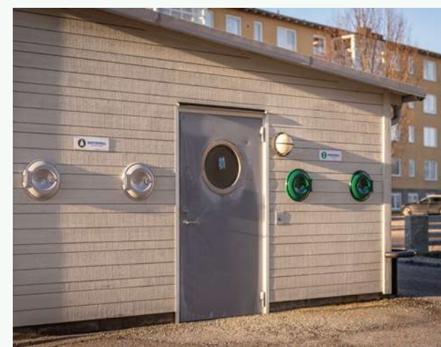
För att skapa bättre ordning i våra miljörum har vissa av dem fått inkastluckor på utsidan.
